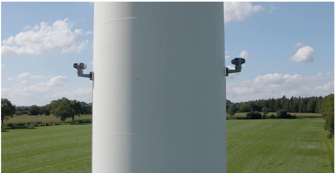
Abbildung 6: Kamerasysteme am Turm der WEA Gnutz-Timmaspe
